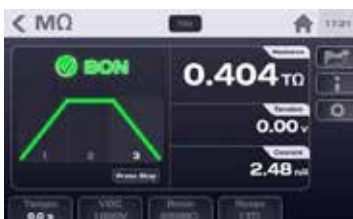
Test Bon terminé
